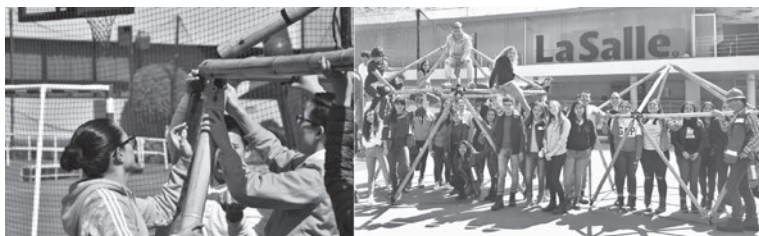
Ilustración 2. Izq. Detalle de ensamble de geodésica de bambú. Der. Geodésicas instaladas, usadas por los alumnos.
